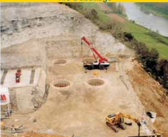
Viaduc de Millau
