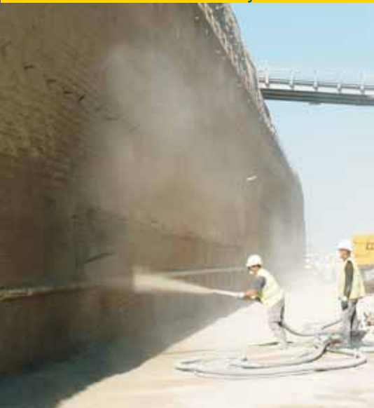
LGV - Tranché de TAISSY - 51
